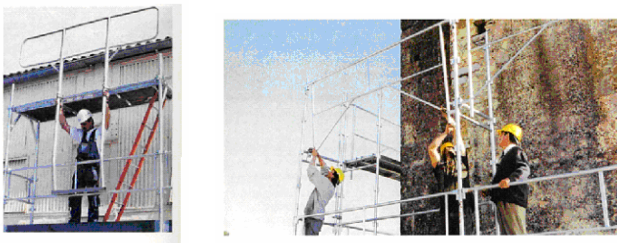
Fig. 1 – Esempio di montaggio dal basso di parapetti di protezione collettiva
