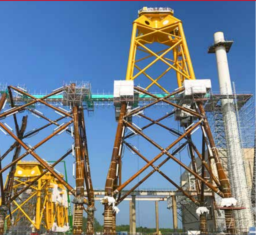
Sistema FW installato con gru | Parco eolico Beatrice
