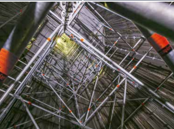
Sistema Allround LW installato nella caldaia di una cartiera
