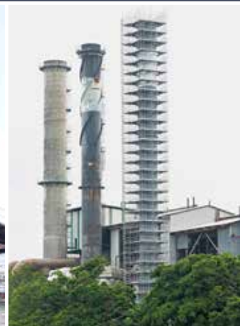
Ponteggio circolare | Raffineria
