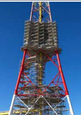
Ponteggio sospeso | Raffineria
