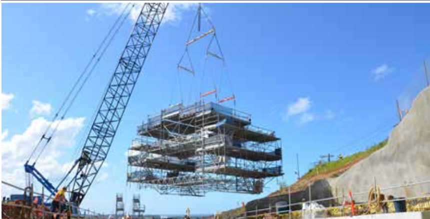
Ponteggio sollevabile con gru per manutenzione galleria stradale
