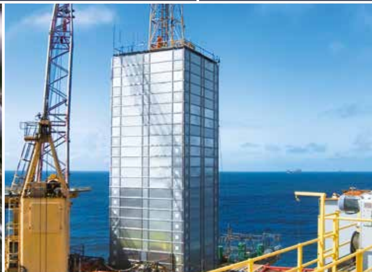
Sistema Protect | Piattaforma petrolifera
