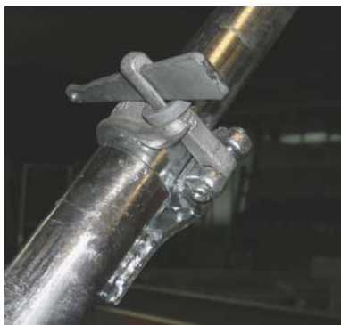
Fig. 1 - Collegamento tubi telescopici
