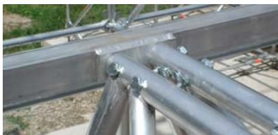
Collegamento delle travi triangolari ai tralici laterali
