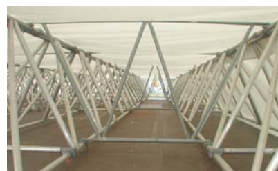
Collegamento travi con traliccio di rinforzo
