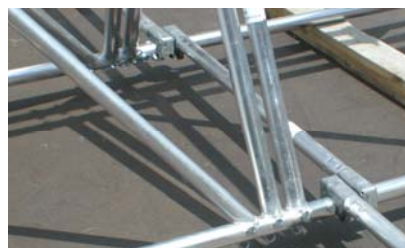
Collegamento inferiore delle travi triangolari
