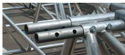
Particolare collegamento travi con spinotto
