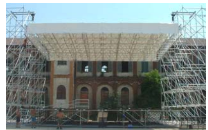
Posizione della copertura prima e durante lo spettacolo
