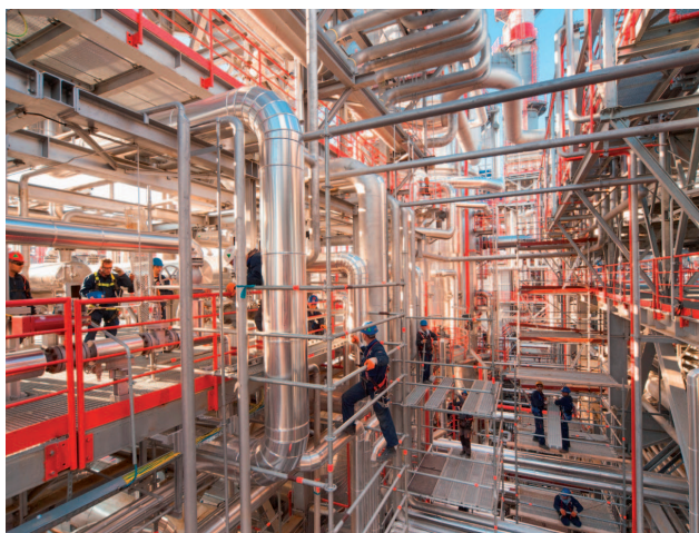
Particolare di raffineria in cui si è utilizzato il ponteggio Layher Allround
