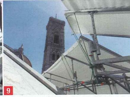
su edifici con facciate irregolari. La sua modularità consente di realizzare un'ampia varietà di strutture con pochi elementi base. Questo sistema di ponteggio infatti utilizza un nodo di connessione privo di collegamenti a bullone, adatto per la trasmissione dei carichi strutturali: in un unico piano è possibile collegare fino a otto elementi ad angolazioni diverse. Ciò è possibile realizzando un collegamento ideale dal punto di vista strutturale e ripetibile ogni 50 cm sui montanti verticali.
