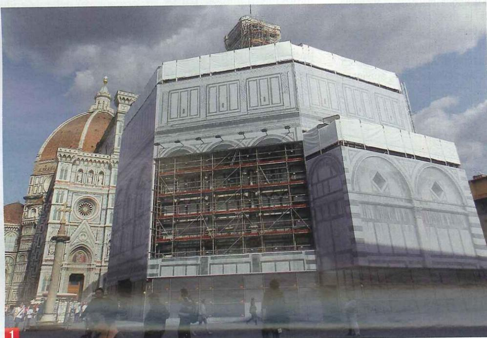
1-2-3. La struttura da ponteggio copre una superficie di circa 3000 mq per un peso di oltre 105 t. Il ponteggio installato ha stilata pari a 73 cm.
