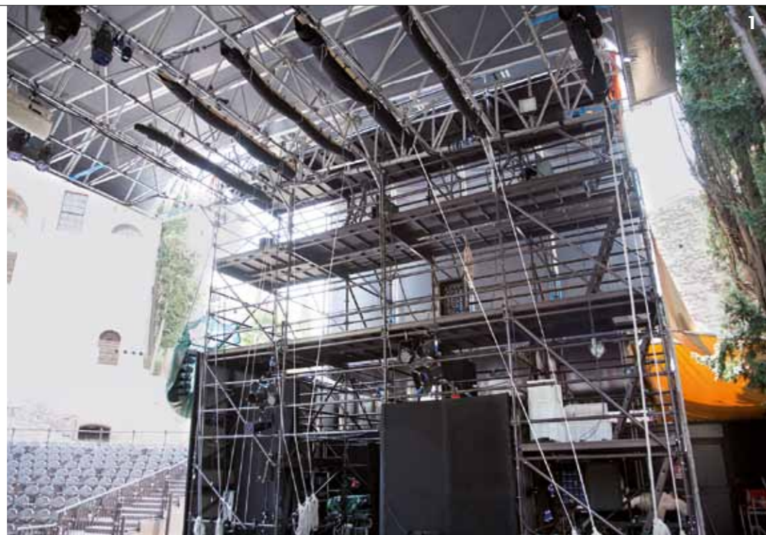
1. La copertura del palco, e il sistema di "mensole" che sostengono la struttura del tetto.
