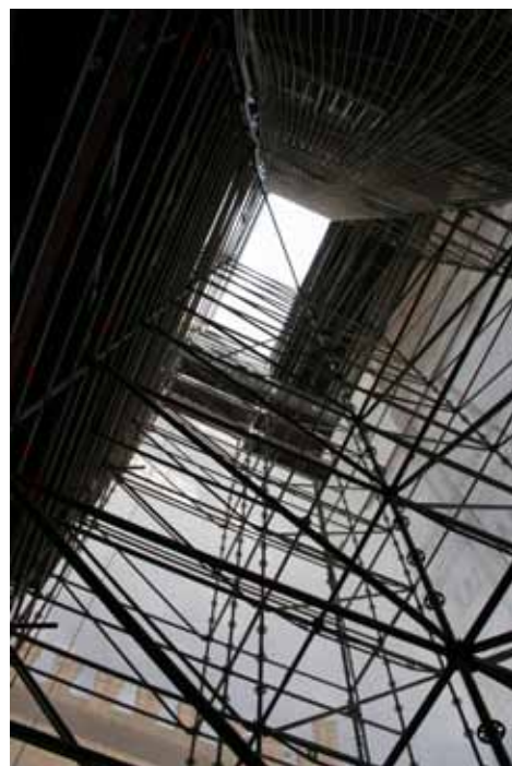
Particolari del sistema di ancoraggio. gli ancoraggi "primari" sono stati realizzati utilizzando le Buche Pontaie lasciate nella facciata dai Costruttori nel lontano 1600
