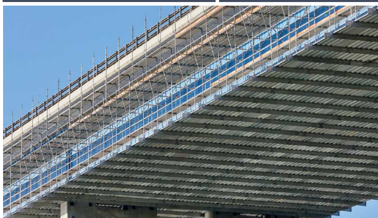
Ampia piattaforma di lavoro sospesa in pochi punti di ancoraggio, priva di controventatura
