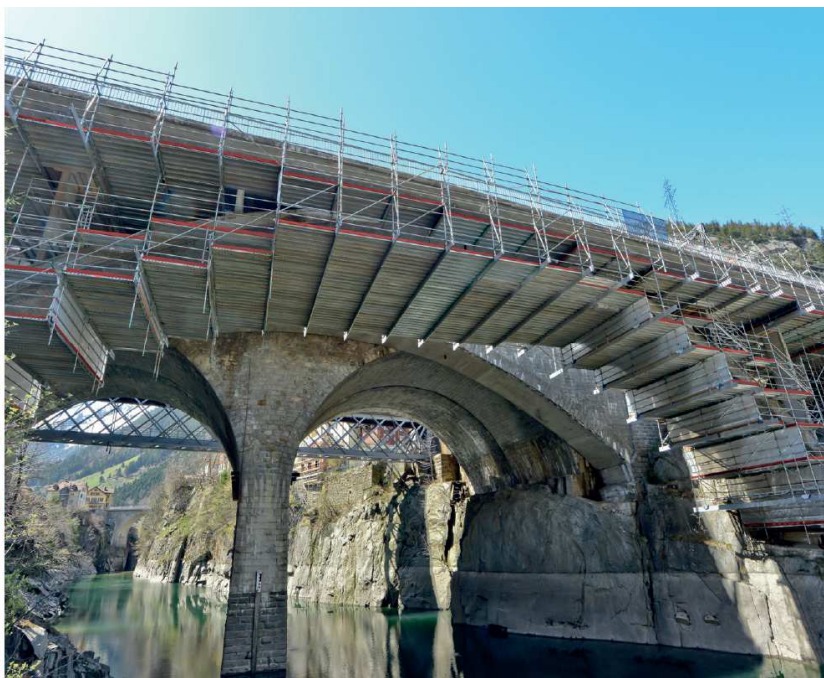
Trave FLEX integrata, dimensionalmente e strutturalmente, ad una struttura Allround
