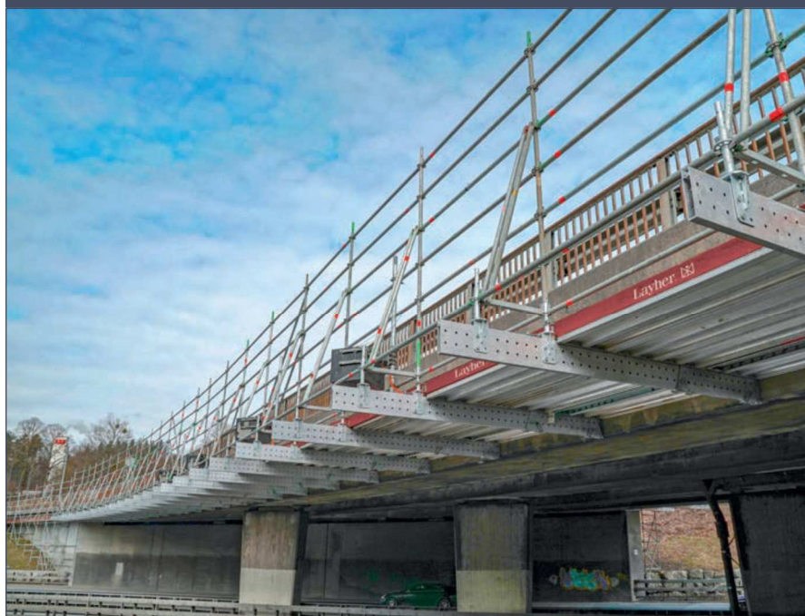
La trave Flex in alluminio utilizzata per realizzare una piattaforma di lavoro sotto un cavalcavia.
